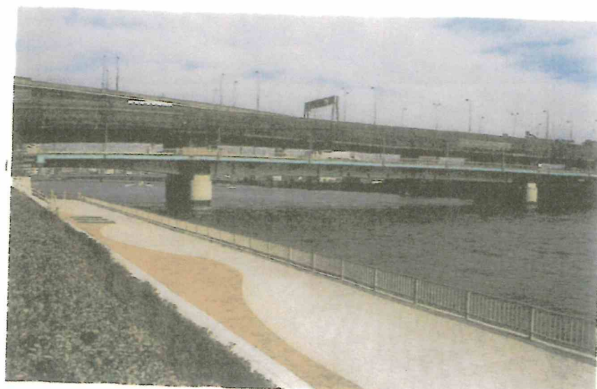
隅田川大橋 Sumidagawa-ohashi
