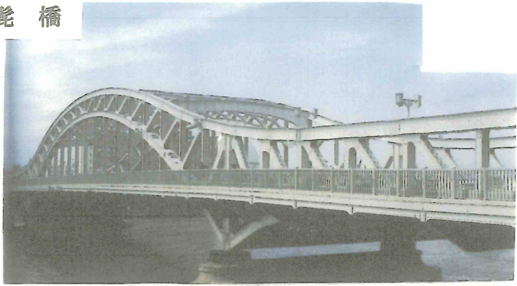
東武線隅田川橋梁
