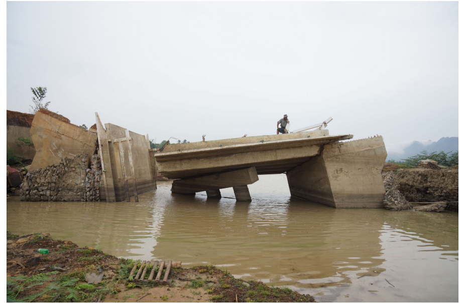
農村開発局が架けた橋 橋台も橋脚も洗掘して崩壊
