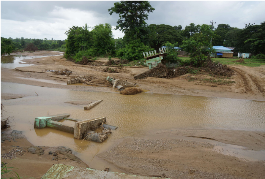
某国NPOが架けた橋 基礎が形だけ
